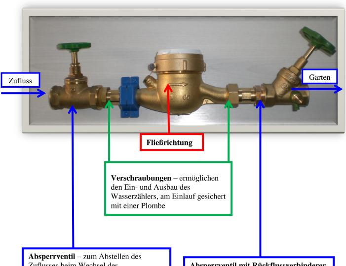
Absperrventil – zum Abstellen des Zuflusses beim Wechsel des Wasserzählers; verhindert das Leerlaufen der Hausinstallation – Trinkwasserversorgung für das Haus muss nicht unterbrochen werden
